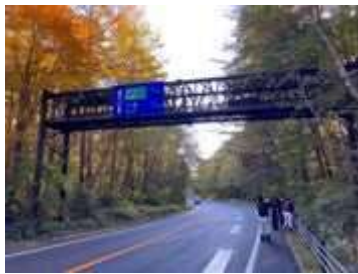
自然との共生の具体策：ヤマネの歩道橋であるヤマネブリッジ
